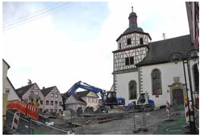
Bauarbeiten neben der Oberstenfelder Dorfkirche. Bild: Rolf Lutz
