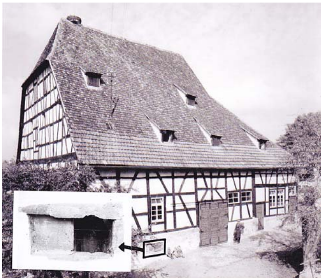
Steinheimer Kelter mit Storchennest und der oberen Zufahrt. Bild wurde im Jahr 1937 aufgenommen. Der Luftschacht ist links unterhalb des Fensters zu sehen.
