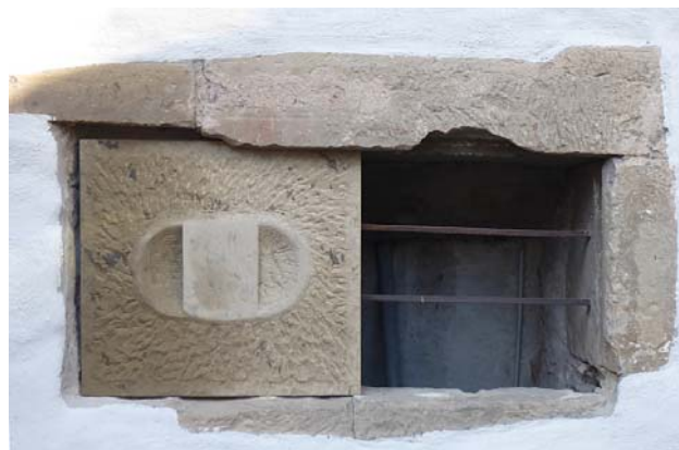
Geöffneter Luftschacht mit dem neu angefertigten Schiebestein. Bild: Dietl
