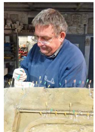
Peter Dietl beim Verpressen der Risse. Bild: Dietl
