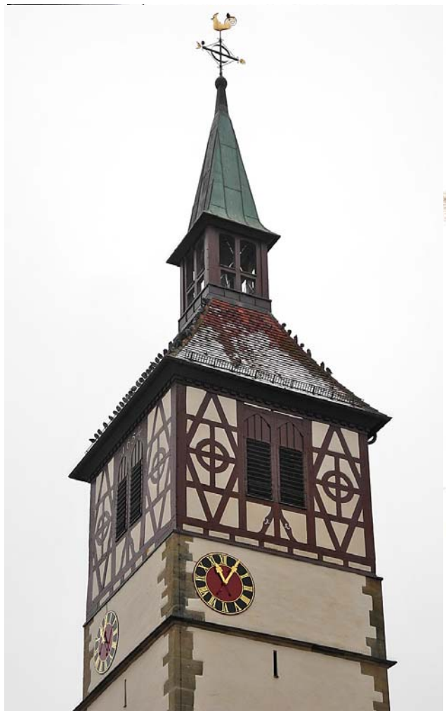
Nach der Zerstörung im Dreißigjährigen Krieg wurde der Turm 1654 wieder aufgebaut und mit dem Fachwerkgeschoss versehen. Bild: RL
