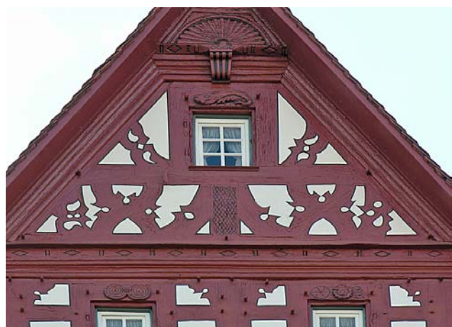
Im dritten Gebelgeschoss des Baumannschen Hauses in Eppingen sind mehrere Streben mit Putzintarsien in Form von Fischblasen verziert. Bild: RL
