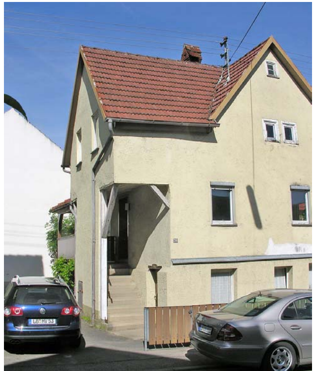
Im vergangenen Jahr wurden in der Gronauer Entengasse die Gebäude einer Kleinbauernstelle abgebrochen, die kleine und unscheinbare architektonische Details (Kamin siehe Bild links) zeigten. Die Wohnung im Hochparterre wurde über eine außenliegende Treppe erschlossen. Um den Wohnraum zu erweitern wurde über dem Treppenaufgang ein Zwerchhaus errichtet, wobei die Treppe faktisch „eingehaust“ wurde (siehe Bild oben). Bild: RL
