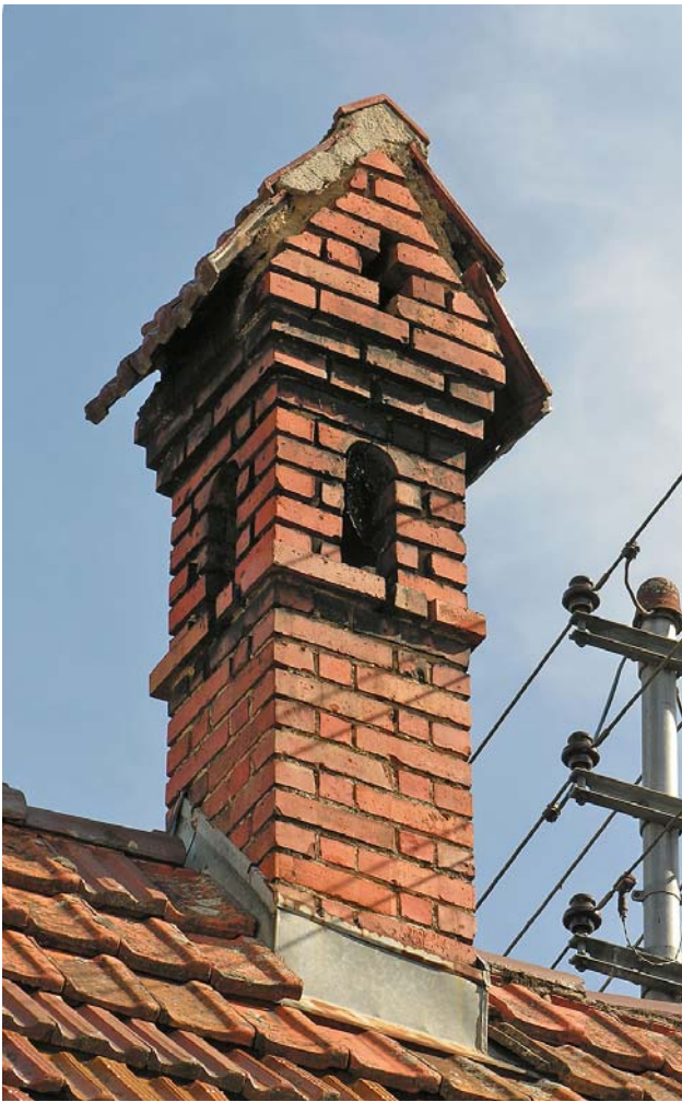
Kaminarchitektur: Die Rauchöffnungen des mit Ziegelsteinen gemauerten Kamins sind mit Rundbögen ausgeführt. Das Kamindach krägt mehrmals über, in den Giebelseiten sind kreuzförmige Öffnungen. Bild: RL
